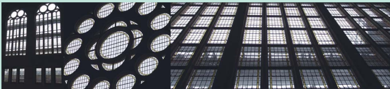
Kirchenfenster, angefertigt mit vorverglastem NDG-Bleiprofil
